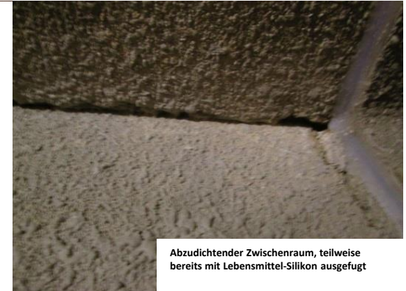
Ausführung der Verputz- und Silikonarbeiten
