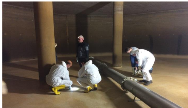
Tief-/ Trinkwasserbehälter, Innenansicht; Prüfung Gesundheitsamt und Hygiene- Institut Bonn
