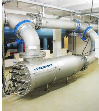
SYMBOL-FOTO einer UV-Anlage zur Trinkwasseraufbereitung
